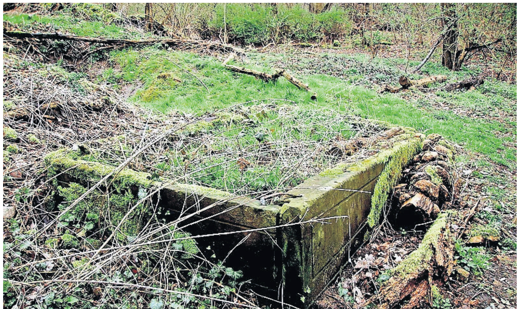
Das bewachsene Sandsteingeviert des Grabes des Gutsherrn von Witten nahe den Gutshaustrümmern und dem Fledermauskeller in Osdorf. FOTO: JENS LEDER
